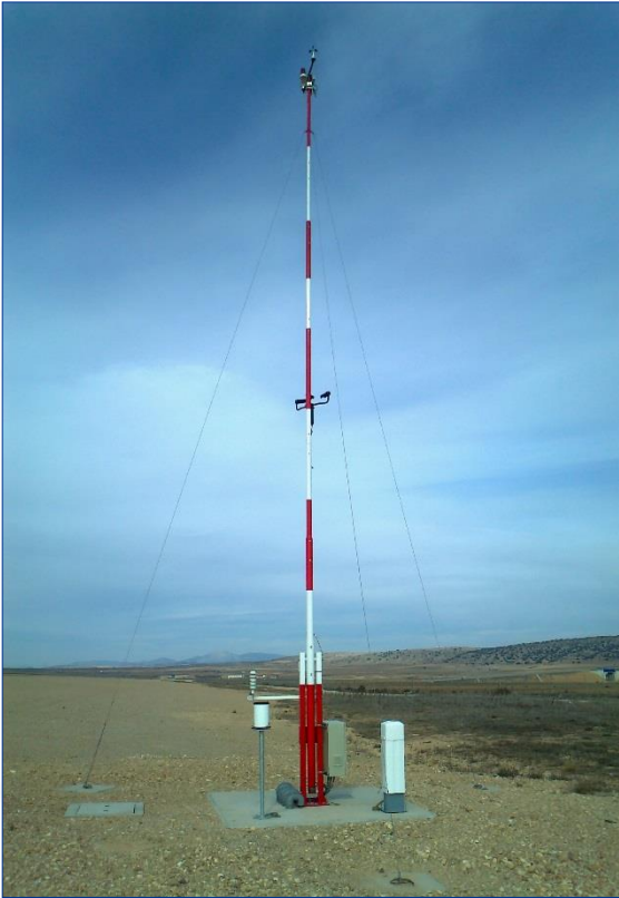
Estación Meteorológica Automática
